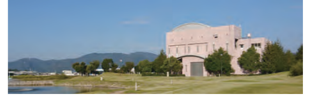
山陽浄化センター
