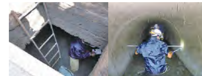
事業対象管渠の詳細調査
