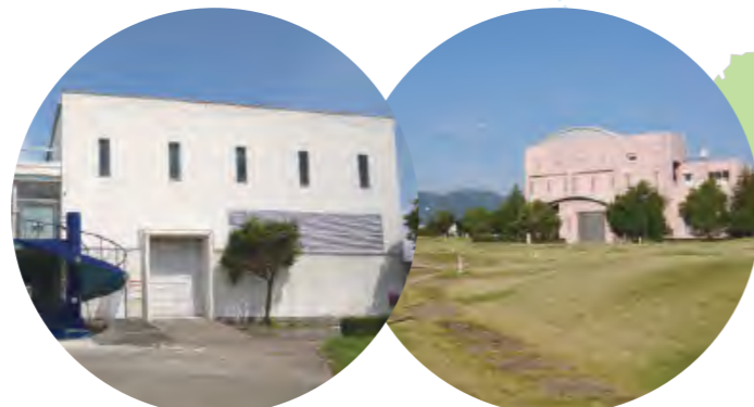
昆陽川捷水路排水機場
