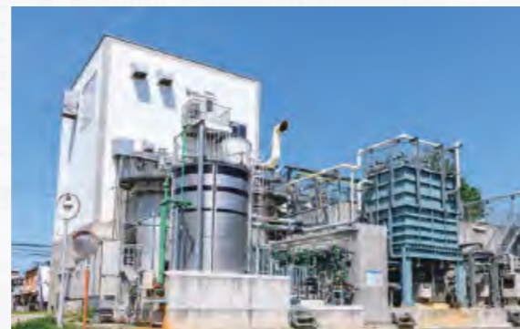
脱水分離液処理施設全景
