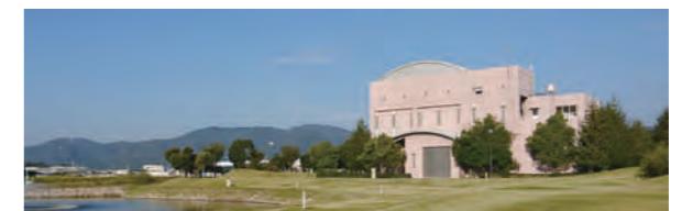
山陽浄化センター
