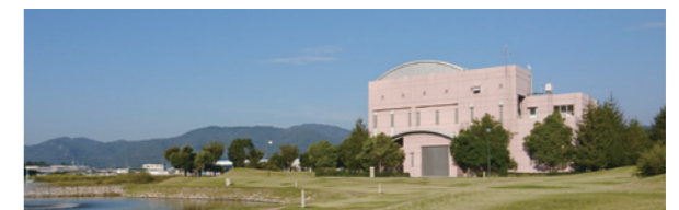
山陽浄化センター
